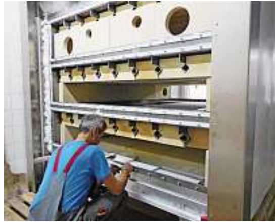
Einbau neuer Pellet-Backofen
